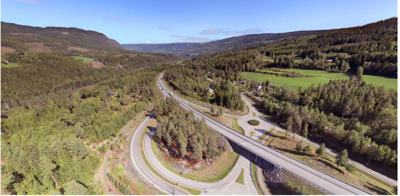
Figur 4-4: Bildet viser Ensbykrysset, sett mot nord. (Illustrasjon: Nye Veier)
