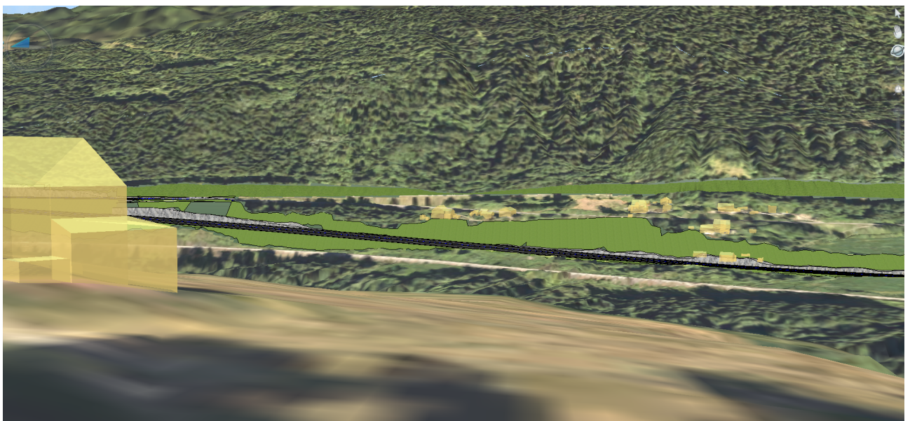
Figur 6-9 Fjernvirkning fra Sveen gård på vestsiden av Gudbrandsdalslågen. Høye jordskjæringene ved Isakstua. Fyllingene midt i bildet, øverst i bildet er igjenfylling av eksisterende E6. Under ser vi jordskjæringene for ny E6.
