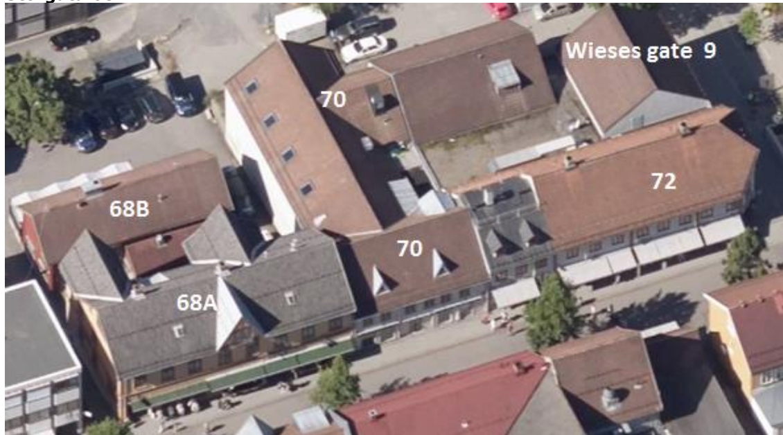
Figur 34 Fasader mot Storgata. (Skråfoto: Blom 2004-2017)
