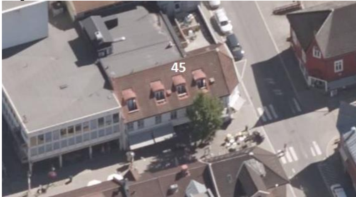
Figur 22 Fasader mot Storgata (Skråfoto: Blom 2004-2017)
