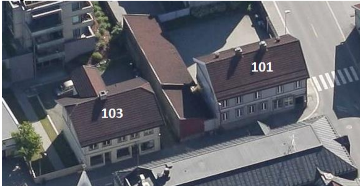
Figur 482 Fasader mot Storgata (skråfoto: Blom 2004-2017)
