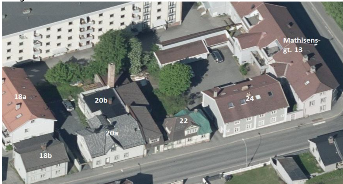
Figur 10 Fasader mot Storgata (skråfoto: Blom 2004-2017)
