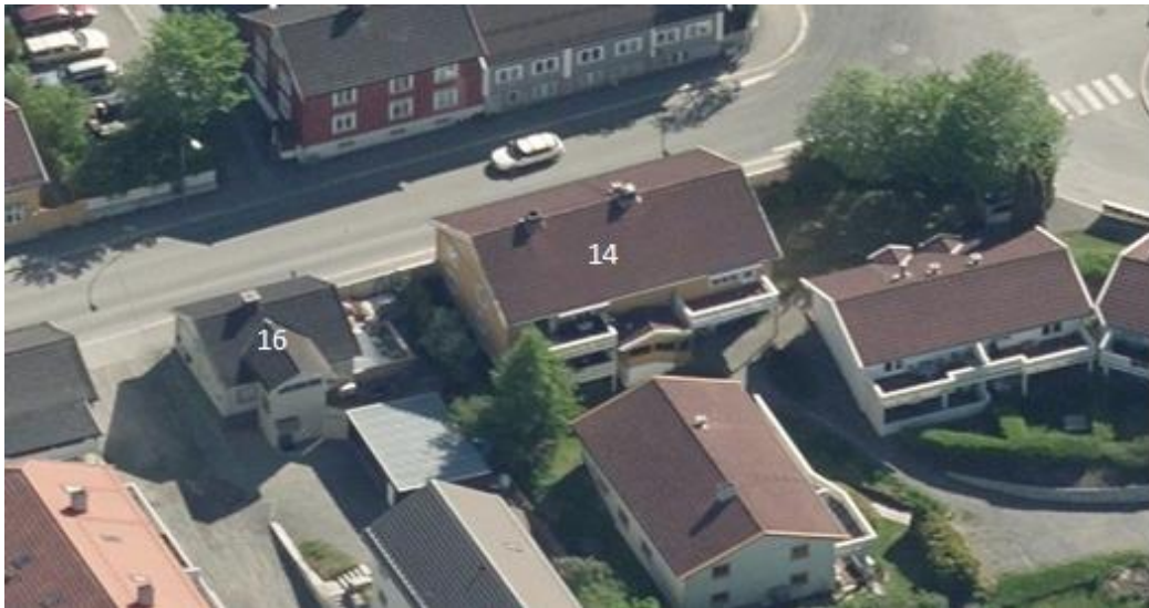
Figur 9 Fasader mot bakgård
