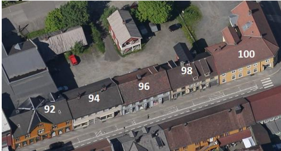
Figur 448 Fasader mot Storgata (skråfoto: Blom 2004-2017)
