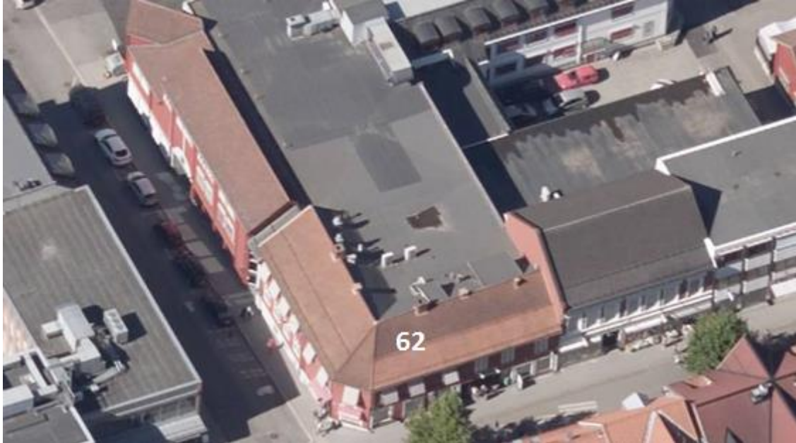
Figur 30 Fasader mot Storgata. (Skråfoto: Blom 2004-2017)
