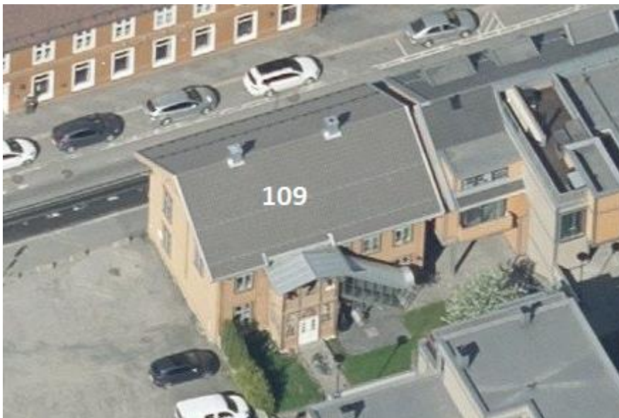
Figur 537 Fasader mot bakgård
