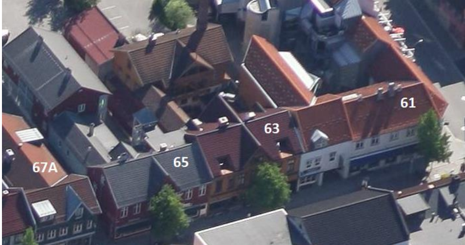
Figur 28 Fasader mot Storgata. (Skråfoto: Blom 2004-2017)
