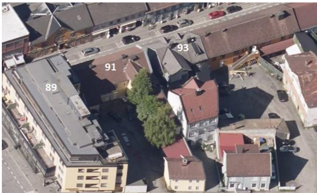
Figur 43 Fasader mot bakgård (skråfoto: Blom 2004-2017)
