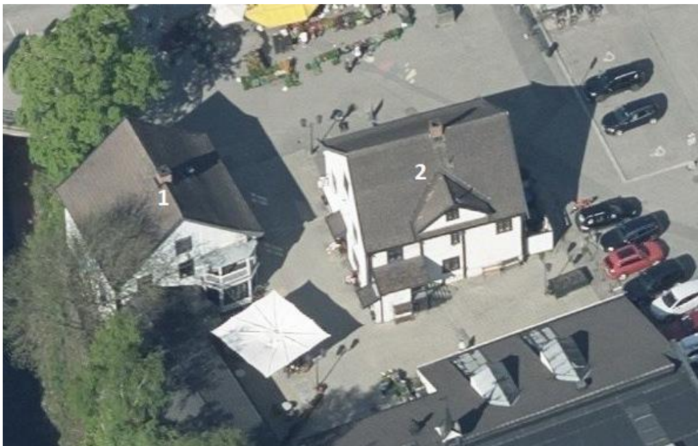
Figur 425 Fasader mot bakgård
