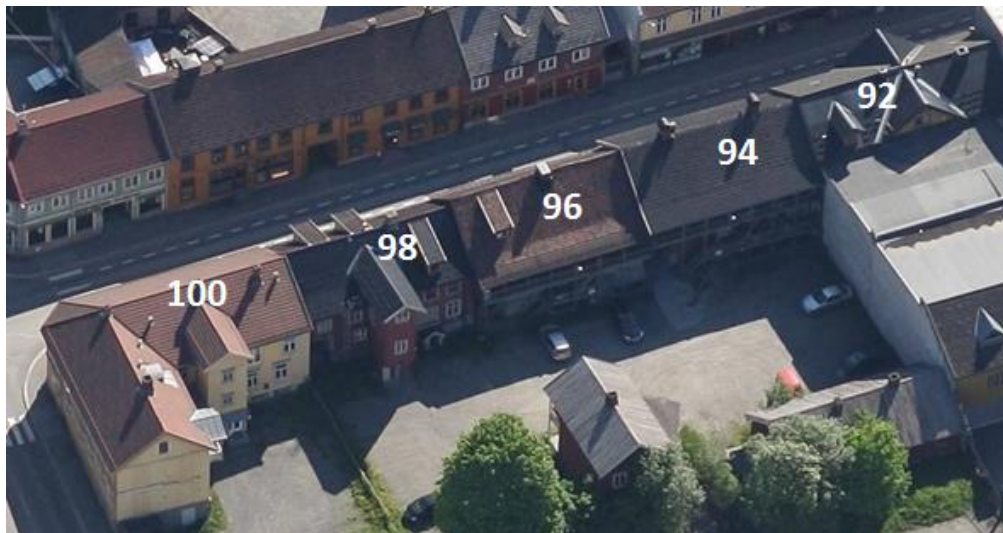
Figur 459 Fasader mot bakgård (skråfoto: Blom 2004-2017)
