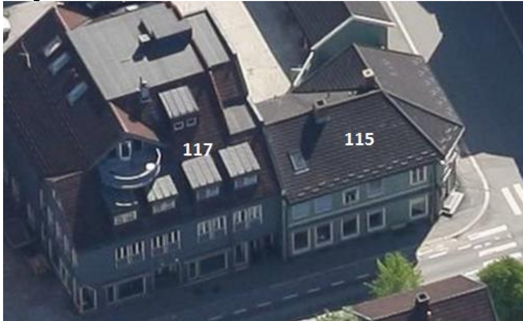
Figur 56 Fasader mot Storgata (skråfoto: Blom 2004-2017)
