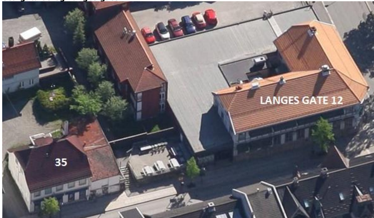
Figur 16 Fasader mot Storgata (Skråfoto: Blom 2004-2017)
