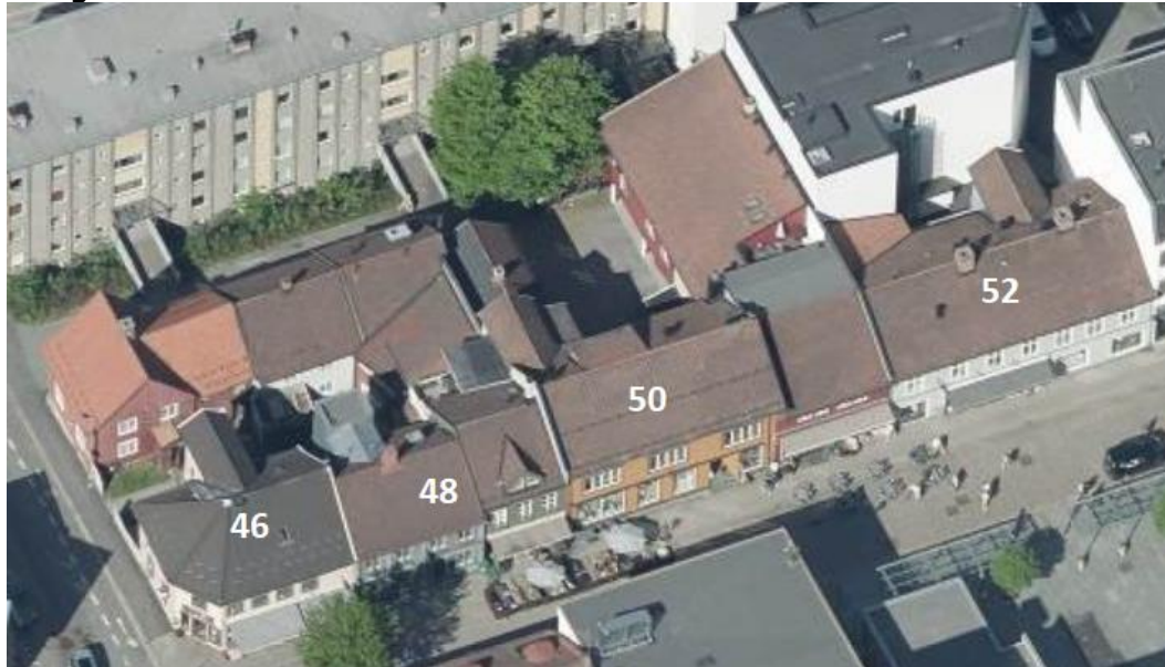
Figur 24 Fasader mot Storgata (Skråfoto: Blom 2004-2017)
