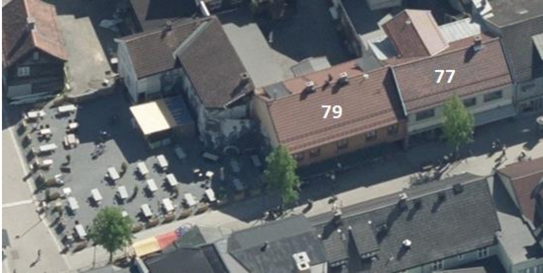
Figur 38 Fasader mot Storgata (skråfoto:Blom 2004-2017)
