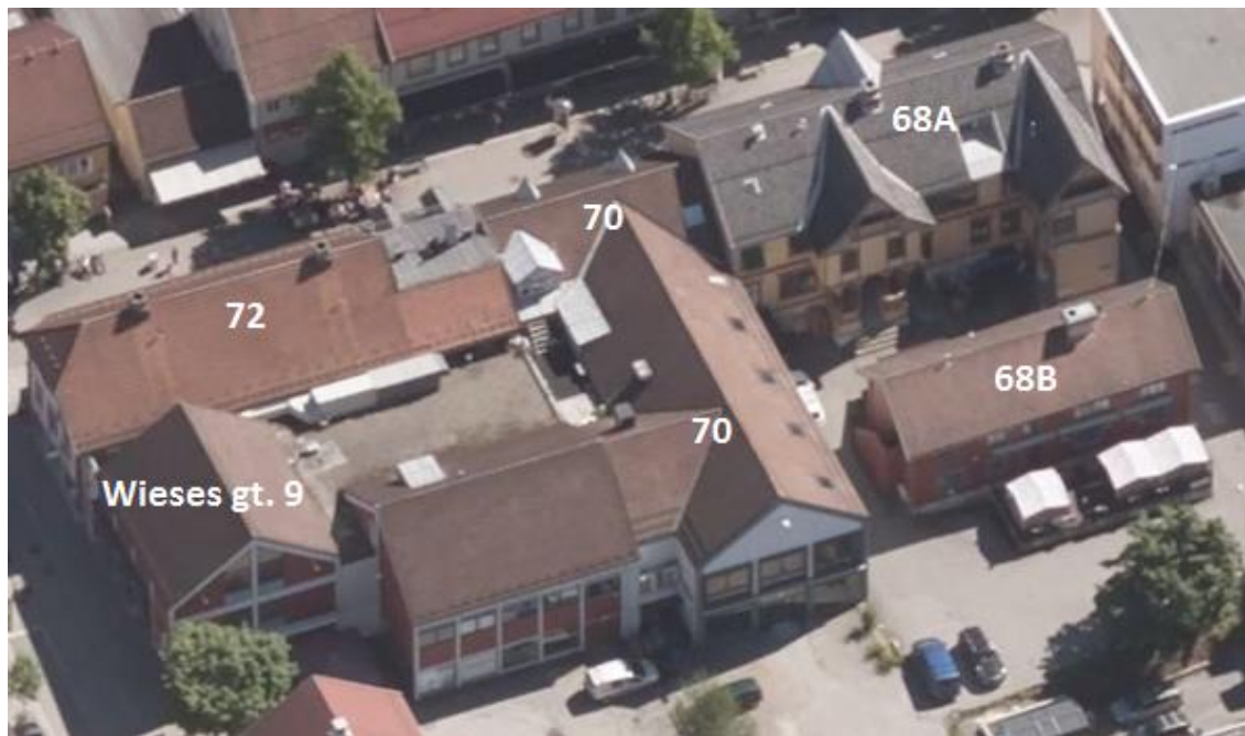
Figur 35 Fasader mot sør/vest (Skråfoto: Blom 2004-2017)
