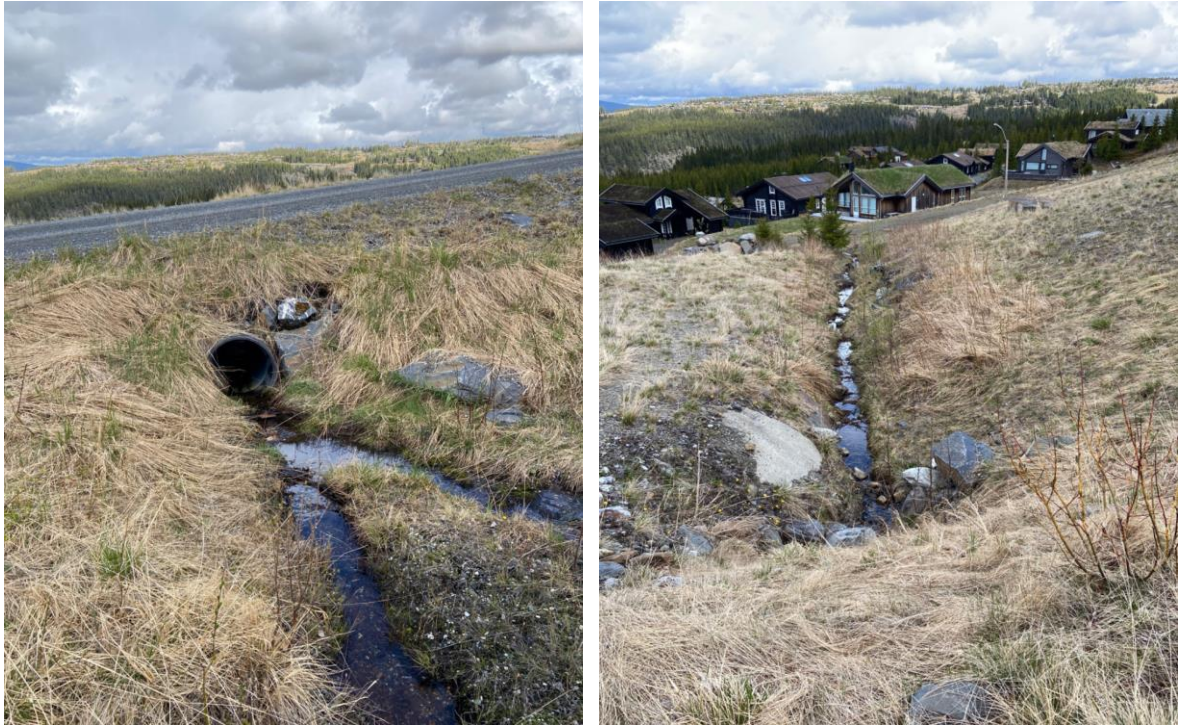
Figur 6: Bilde, stikkrenne under Stuttingen og videre nedover utenfor planen. (Multiconsult)
