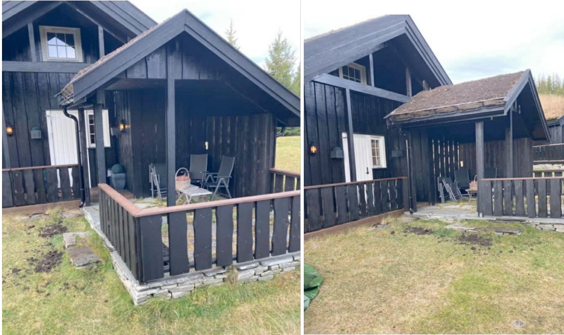
Bilde av overbygd terrasse
