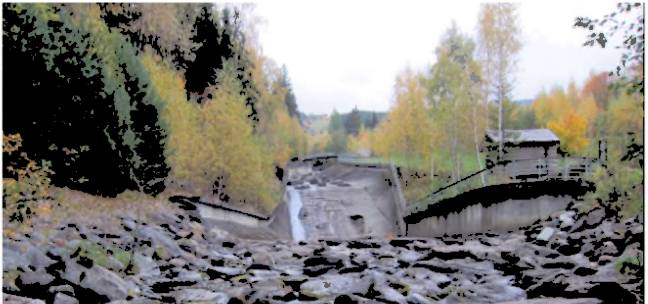
Sikringsanlegg i Moksafoto Øyer kommune
