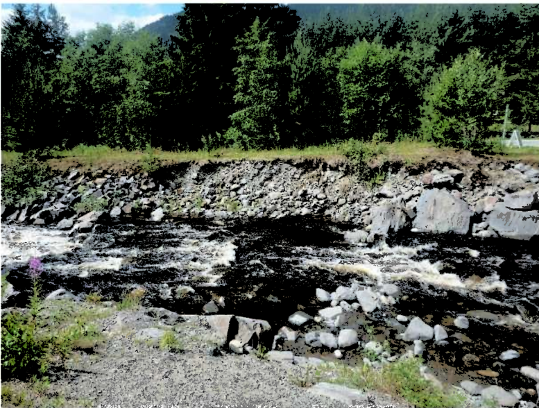
Figur 9: Erosjonsskader nedstrøms nest øverste bru
