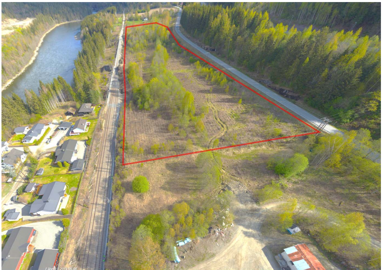
Figur 5-5: Deponi Fåberg skog, merket med rødt, sett mot nord fra Fåberg. Området har tidligere vært benyttet til landbruk og kan heves og reetableres som landbruksområde.
