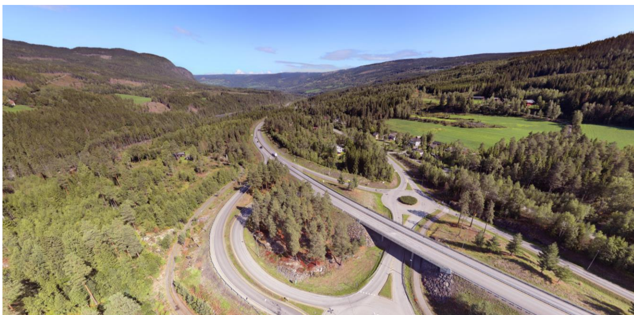
Figur 4-4: Bildet viser Ensbykrysset i Øyer kommune, sett mot nord. (Illustrasjon: Nye Veier)
