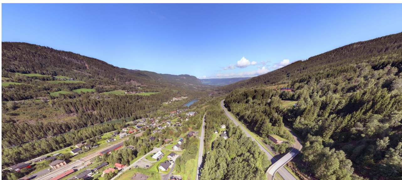
Figur 4-2: Tettstedet Fåberg i framgrunnen, med E6 til høyre, jernbanen og Gudbrandsdalslågen til venstre i bildet. (Illustrasjon: Nye Veier)
