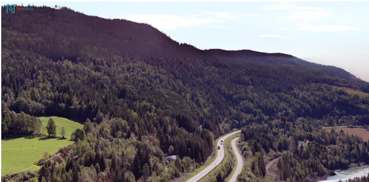
Figur 10: Dronefoto tatt sørover fra Einsby. Foto viser bratt skråning og skredutsatt strekning ved Isakstua (Nordicskytech.com, 2018).
