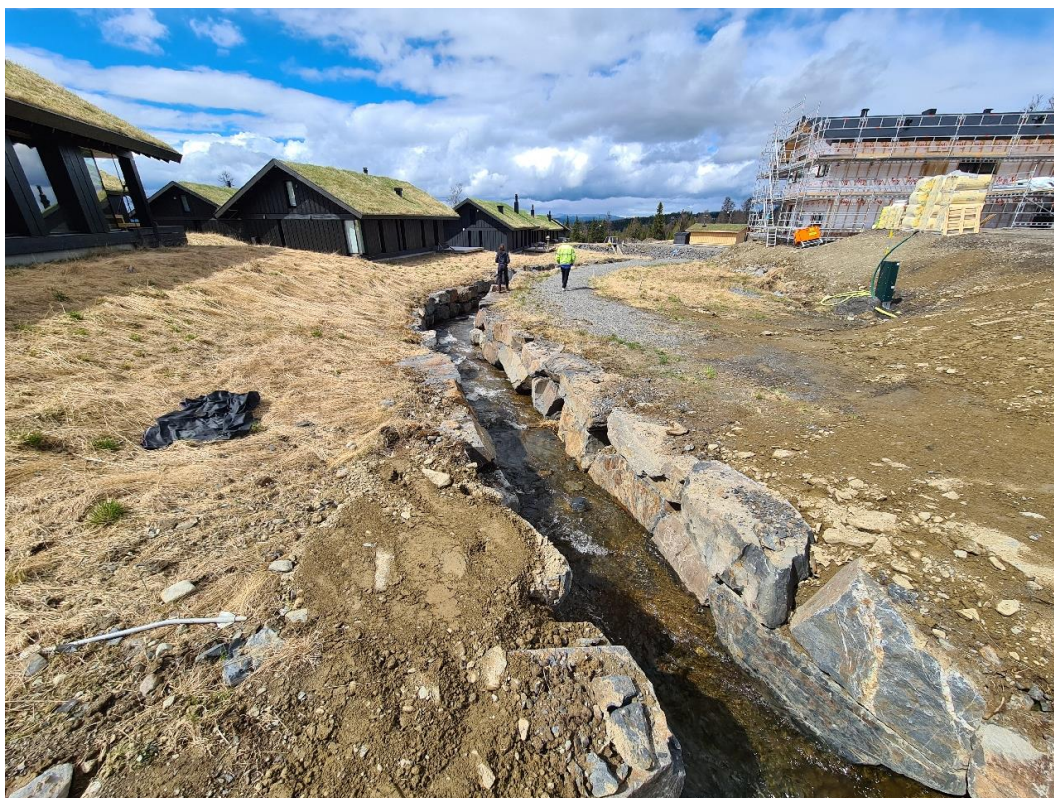
Figur 4-2: Bekkeløp i Nørdre Slåbekken, oppstrøms FLS3
