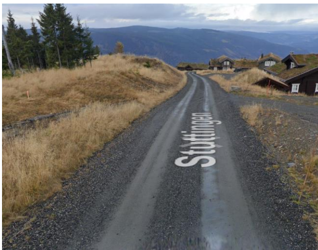
Figur 29: Adkomst via Stuttingen som reguleres med fem meter bredde pluss sideareal (Google maps)
